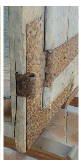
Fig. 4 - Les système de rotation (paumelle et couplet).
