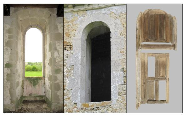
à cette demi-croisée de conserver en totalité ses éléments cintrés (fig. 12). On notera que la sousface de la traverse haute du volet demeure rectiligne à l'instar des exemples précédents pour simplifier sa fabrication (fig. 12).
