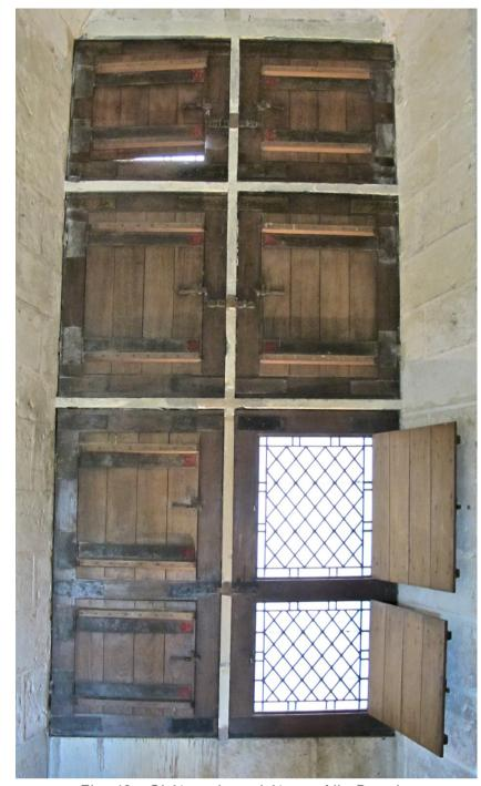
Fig. 49 - Châteaudun, château. Aile Dunois. Les croisées restituées par l'architecte Jean Trouvelot à partir de 1938 selon le modèle d'origine. Photo A. Tiercelin
