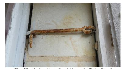
Fig. 23 - Ardon (Loiret), château de Boisgibault A gauche, la croisée. A droite, les persiennes ferrées sur un bâti dormant, l'ensemble étant maintenu par des crochets à la croisée.
