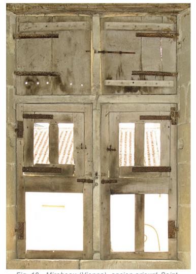
Fig. 10 - Mirebeau (Vienne), ancien prieuré Saint-André En haut, les volets sont d'origine En bas, les vantaux vitrés ont remplacé deux volets du même type.
